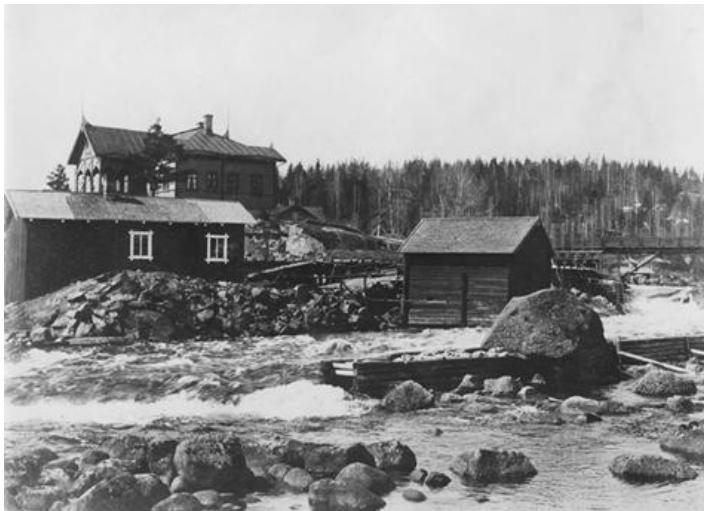
Patruunan Pytinki kuvattuna ennen vuonna 1898 valmistunutta tornimaista, kosken puoleista laajennusosaa. Rakennuksen kattomuoto muutettiin laajennuksen yhteydessä kuvassa näkyvästä aumakatosta nykyisenlaiseksi.
