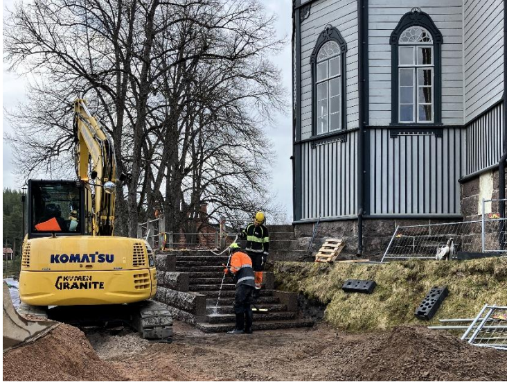
Konttoripäädyn betoniporras korvattiin graniittiportailla.
