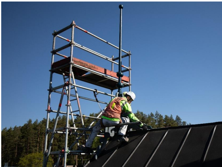
Vesikattoon ja julkisivuihin tehtiin huoltomaalaukset.
