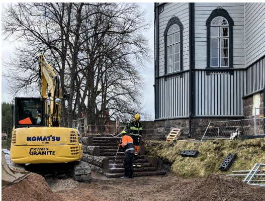
Konttoripäädyn betoniporras korvattiin graniittiporraisilla.
