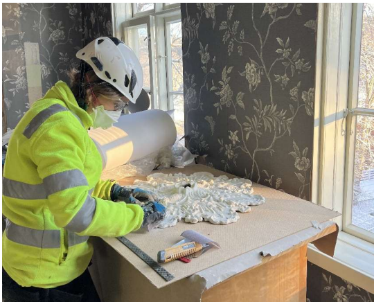
Paperimassasta valmistetut kattoroseeteista käyttökelpoiset kunnostettiin ja asennettiin takaisin paikoilleen.
