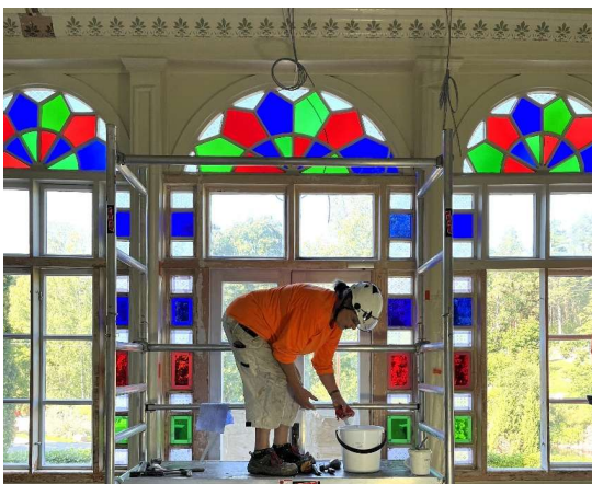
Pääsisäänkäynnin lasikuistin värilasi-ikkunat entisöitiin paikoillaan, jotta minimoitiin riski lasien rikkoontumiselle.
